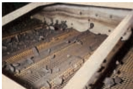
●稼働中のウェーブスクリーン
